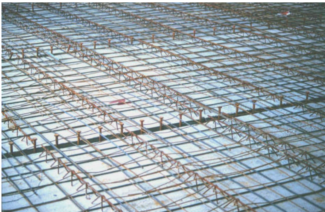
Fig. 1.3: soletta collaborante con lastre Predalle
